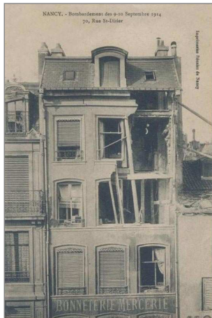
Bombardements des 9 et 10 septembre 1914 - bonneterie mercerie de la rue de Saint Dizier.
