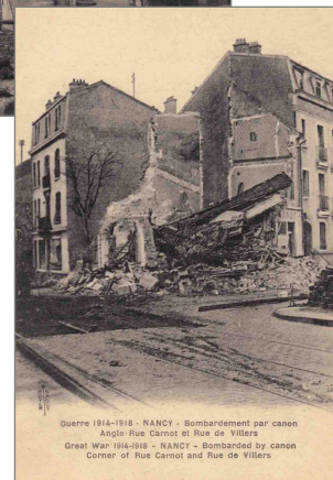
Bombardement du 1 er janvier 1916 - destruction de la maison à l'angle de la rue Carnot et de la rue de Villers.
