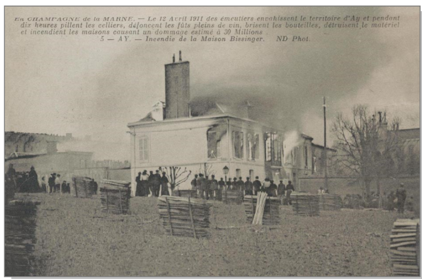
La Maison Bissinger en flammes.
