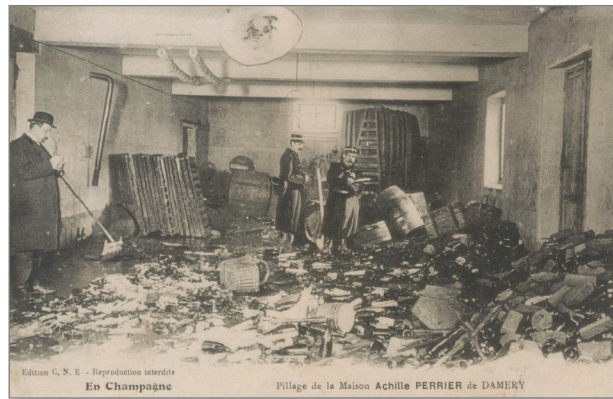
La Maison Achille Perrier de Damery après le passage des émeutiers le 17 janvier 1911.
