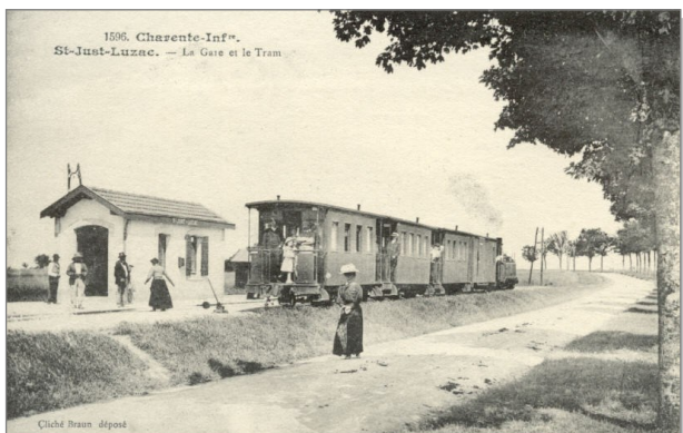
4 À St Just-Luzac, la station est en surplomb de la route de Saintes à Oléron.
